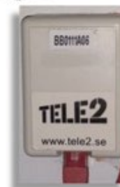
Bilden visar hur fiber/bredbandsuttaget kan se ut.
